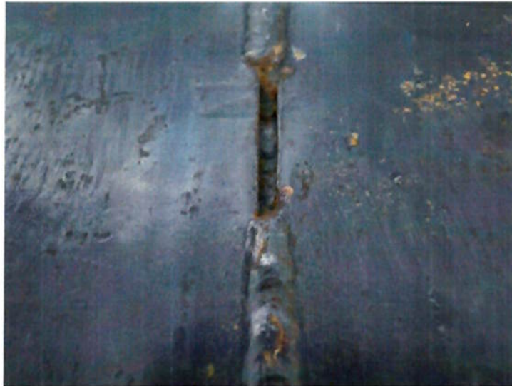
Figura 2.12 – Falta de penetração Fonte: Poliend
