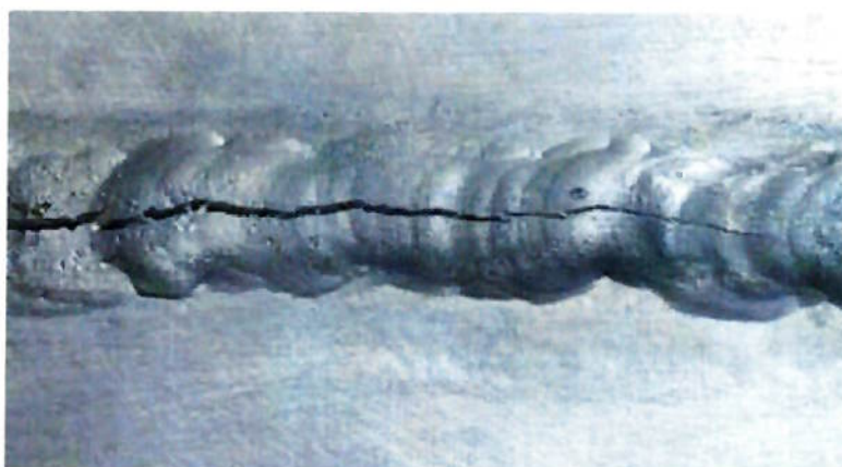
Figura 2.13 – Imagem de trinca longitudinal Fonte: Poliend
